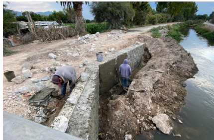
Construcción de accesos en puente y muros de contención, La Mora.
