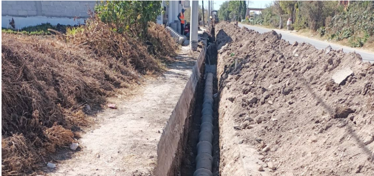
Construcción de drenaje sanitario en Avenida Juárez, San Juan Tepa.
