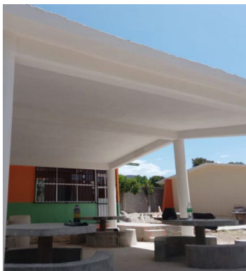
Construcción de comedor en Esc. Prim. Cinco De Mayo, El Horno.
