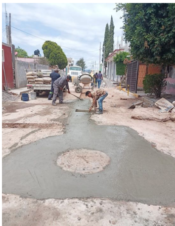
Reconstrucción de concreto hidráulico calle Luis Villareal Y Aquiles Serdan, Lázaro Cárdenas.
