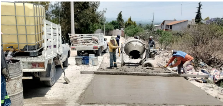
Construcción de pavimento hidráulico, calle Los Hernández, San Antonio.
