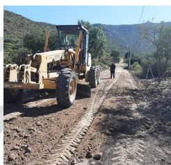
Construcción de terracerías en calle Lázaro Cárdenas.
