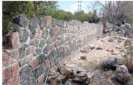
Apoyo con piedra, arena y mortero para la construcción de muro Esc. Sec. Fed. Felipe Angeles, San Juan Tapa.
