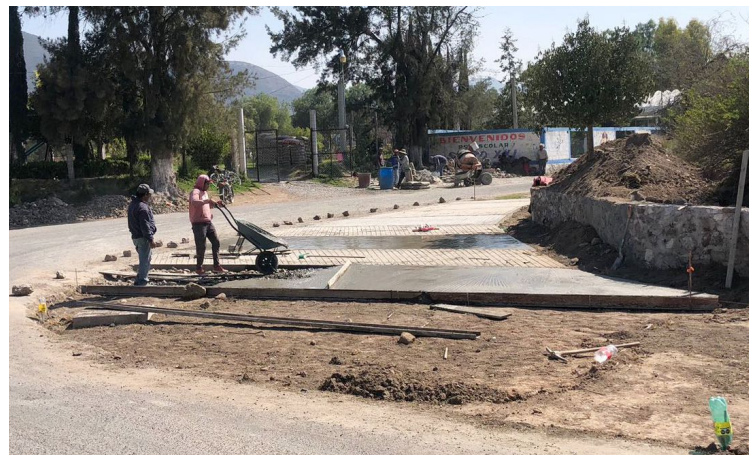
Construcción de pavimento hidráulico en calle de acceso a El Veinte.
