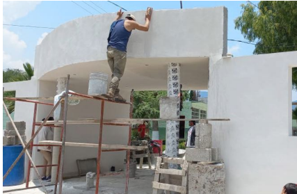
Construcción de fachada en Escuela Primaria Rafael Ramírez, Arambó.
