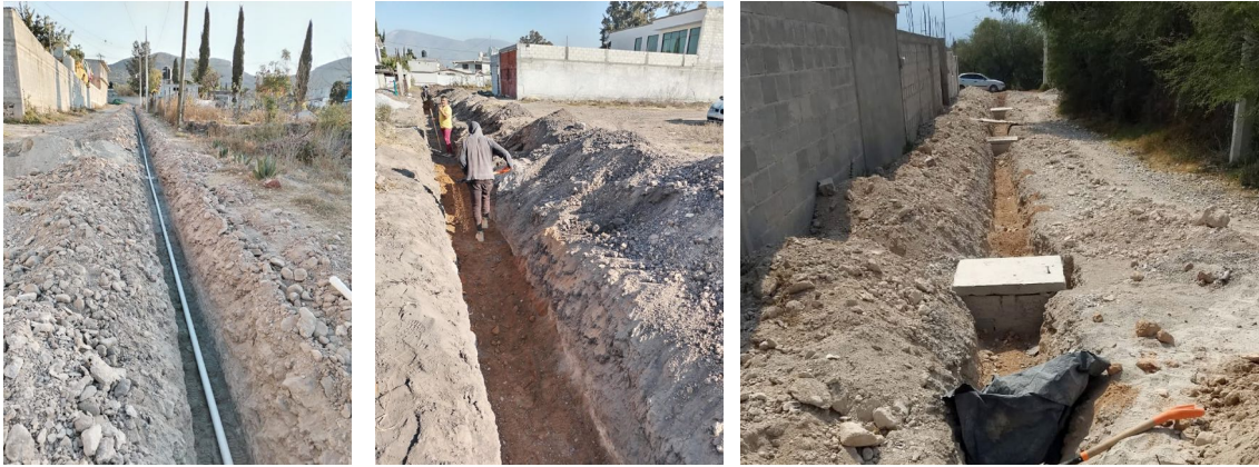
Construcción de red de agua potable, Calle 12 de marzo. Construcción de red de agua potable, Calle 19 de marzo.
