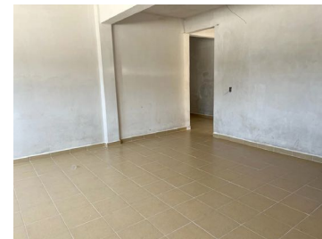
Colocación de loseta, acabados e iluminación en foro de San Juan Tepa.
