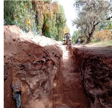
Construcción de drenaje sanitario en calle de acceso Colonia La Cruz.
