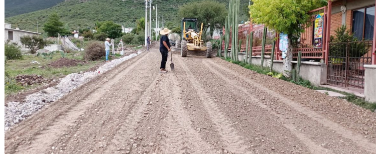
Construcción de terracerías en calle Independencia, Los Filtros.
