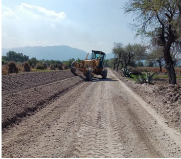
Construcción de terracerías de base hidráulica en calle Sinaloa, Dengantzha.
