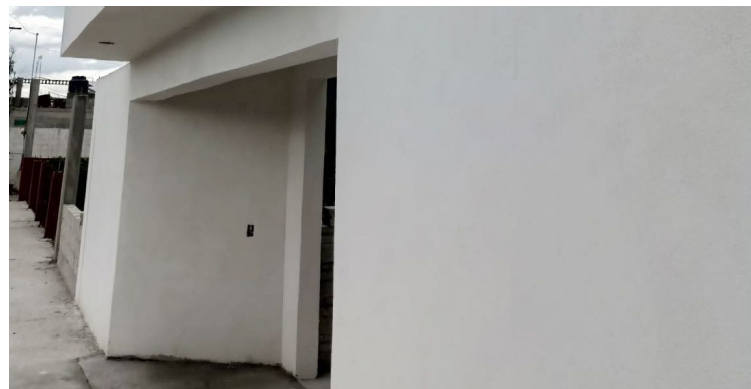
Construcción de fachada Esc. Prim. Escuadrón Aéreo 201, La Puerta. 2ae
