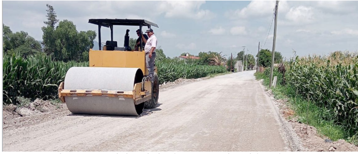
Construcción de terracerías de base hidráulica en Avenida Hidalgo, El Rosario.
