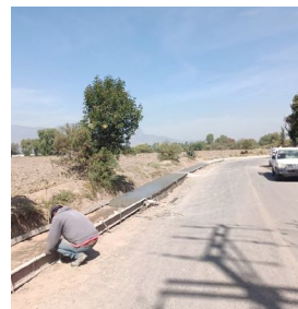
Construcción de banquetas y guarniciones en calle principal, El Veinte.
