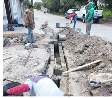
Construcción de regillas para drenajes pluviales en la calle 2 De Abril, 3ra. Demarcación.
