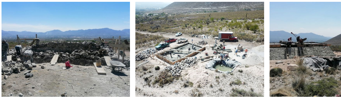
Construcción de red de un tanque agua potable en el Mendoza.
