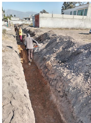
Construcción de red de agua potable, Calle Alberto Ángeles Mejía Colonia: 2da. Demarcación.
