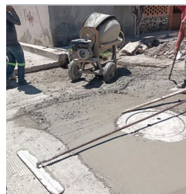
Construcción de guarniciones y banquetas en Calle Desague Norte, 3ra. Demarcación.
